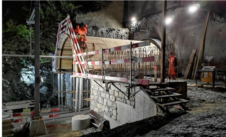
Abb. 18: Typische Verhältnisse beim Neubau eines NBW-Portals auf der UNESCO-Strecke Albulalinie
