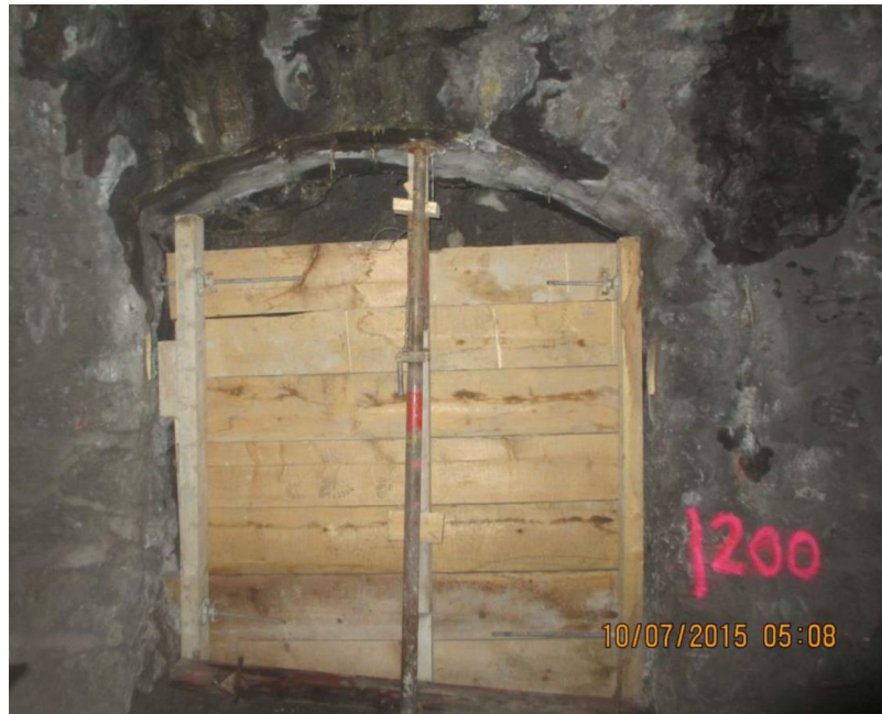
Abb. 4: Natursteinauskleidung mit eingestürzter Schutznische für das Personal
